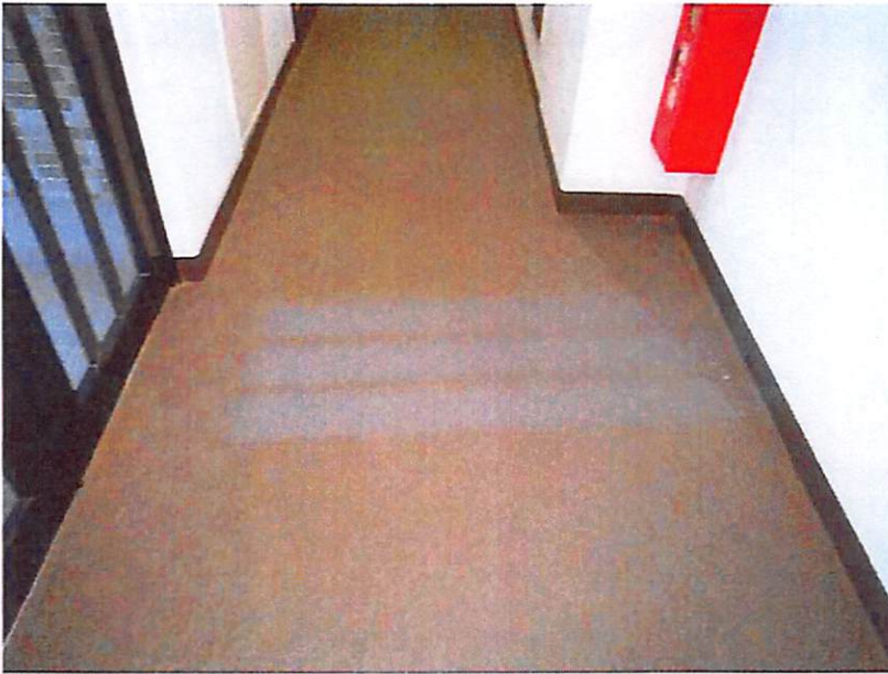
作業前 共用通路
